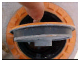
Spill bucket lid gasket
